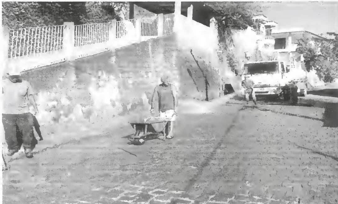
Limpeza da Rua Leonarda Fraga – 05/02/2014.
